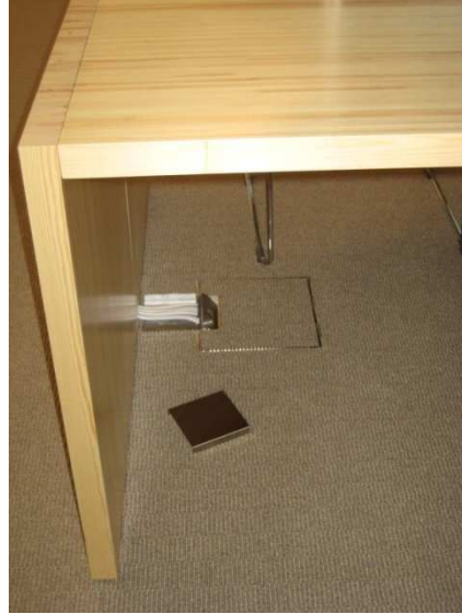
Figura 16: Tapa de registro puntual.
