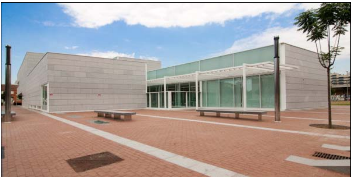
Figura 13. Vista desde el otro lado del acceso
